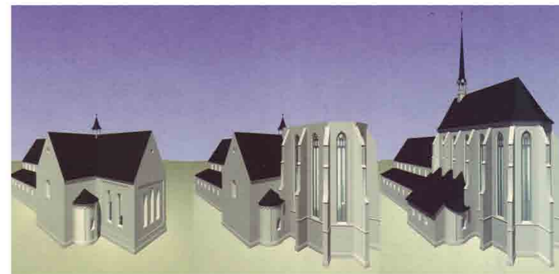
(v.l.n.r.) Die Rekonstruktion der Predigerkirche Zürich im romanischen Zustand nach 1230, im gotischen Zustand um 1320–30 während eines mehrjährigen Bauunterbruchs (das Dach fehlte) und im vollendeten Zustand um 1350. Visualisierung: Marco Kohler, Stäfa; modelliert in «ZOOM» und «form+Z», gerendert in «RenderZone» und animiert in «Cinema»
